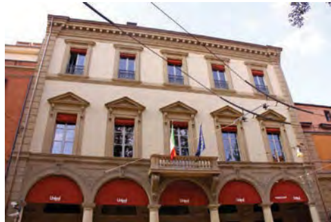
Palazzo Fantuzzi in via Farini a Bologna, sede di Unipol Banca: l'impianto di sicurezza è stato ristrutturato da Teleimpianti
