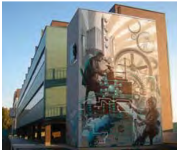
La nuovissima sede Bugnion in via di Corticella a Bologna. Teleimpianti ne è stato il partner tecnologico per tutti gli impianti speciali
